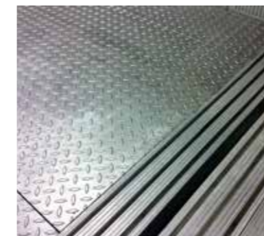
Détail de plancher larmé
